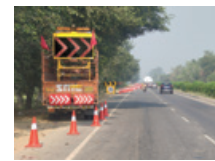
▲交通規制材を使用した実証実験の様子
