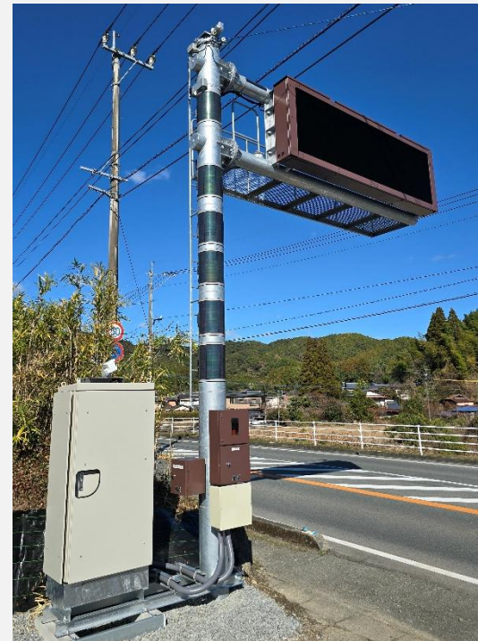
▲支柱部にカルコパイライト太陽電池を設置
