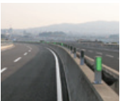
走光型運転支援灯システム
