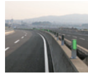
走光型運転支援灯システム
