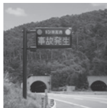
トンネル防災システム
