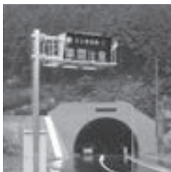
トンネル防災システム
