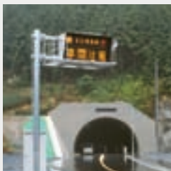
トンネル防災システム
