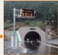
トンネル防災システム
